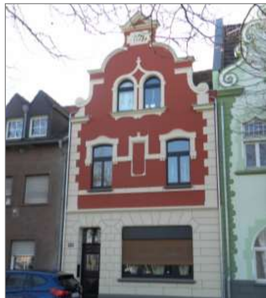
Abb. 15: Förderobjekt im Hof- und Fassadenprogramm (Quelle: DSK 2018)
