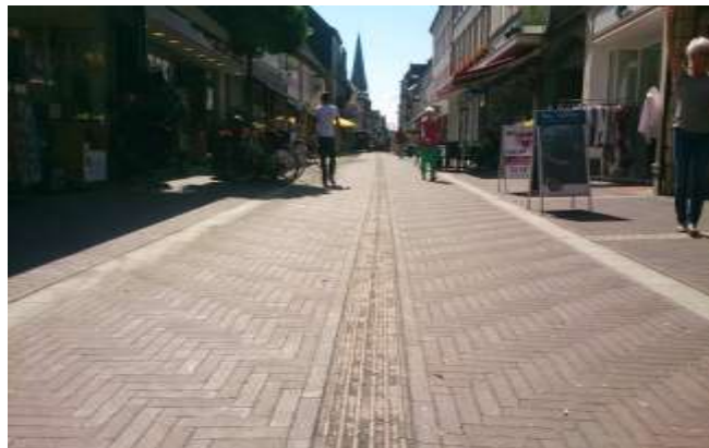
Abb. 7: fertiggestellter erster Bauabschnitt im Juli 2018 (Quelle: DSK-BIG 2018)
