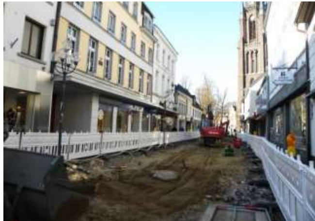
Abb. 6: Baumaßnahme Hauptstraße, Februar 2018 (Quelle: DSK-BIG 2018)
